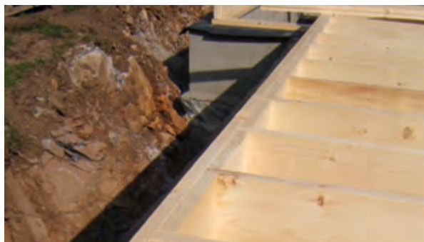
L'ossature vent s'asseoir sur la maçonnerie.
