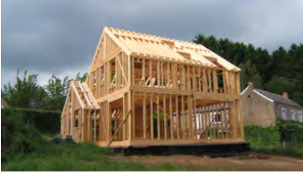
Toute l'ossature est terminée.
