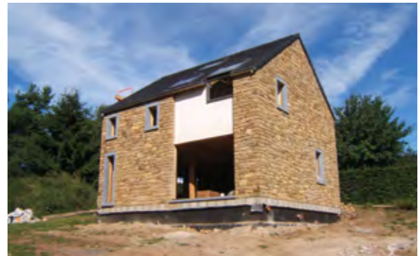
La voilà prête à recevoir les châssis.
