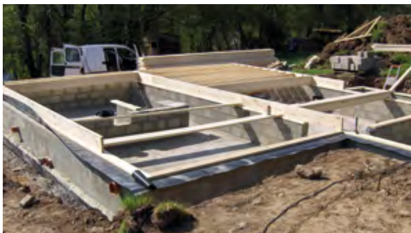
Après la maçonnerie, l'amorce de l'ossature bois.
