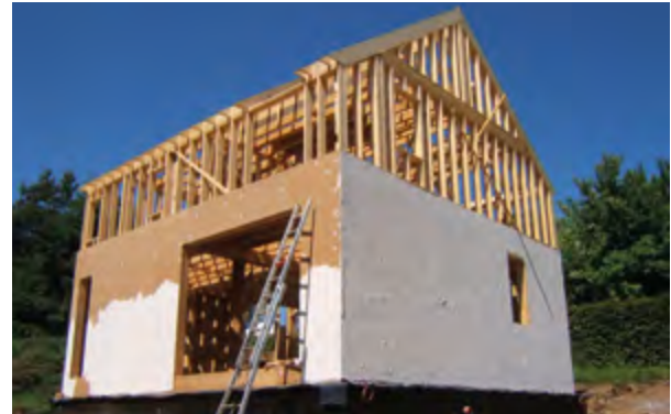
L'ossature bois habillée de Diffutherm et badigeonnée d'un crépi.
