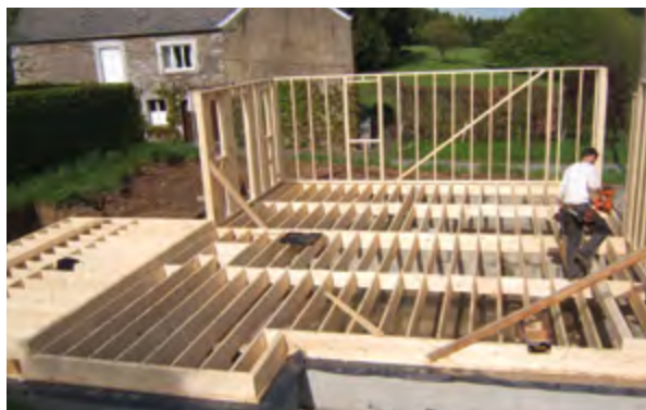
L'assise est terminée, on peut entamer les murs.
