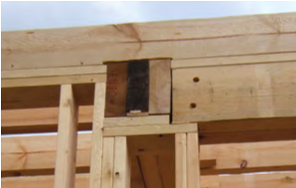
Détail d'encastrement de la poutre porteuse centrale.
