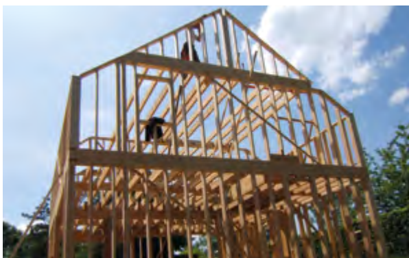
L'ossature quasi terminée.
