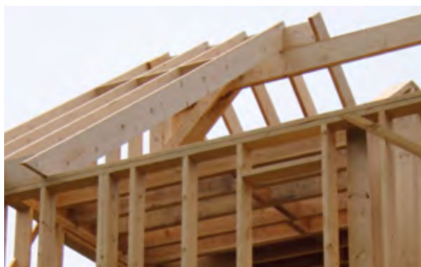
On en est déjà à la charpente.
